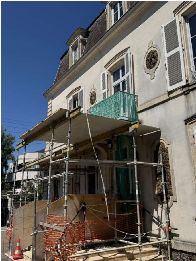
Structure balcon à réparer et consolider
