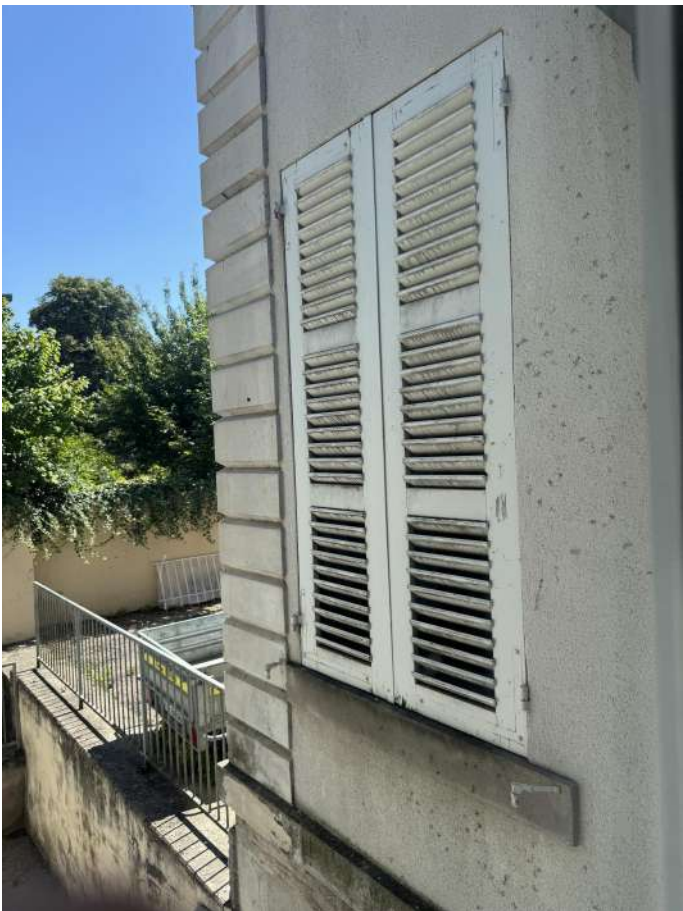
Effritement pierre du chaînage d'angle
